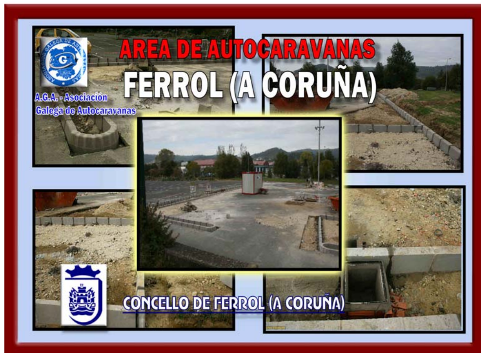
AREA AUTOCARAVANAS FERROL (A CORUÑA) EN CONSTRUCCIÓN
